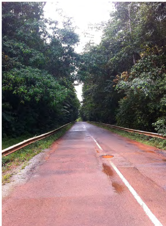
La route nationale 2 relie Matoury à Saint-Georges-de-l'Oyapock à la frontière du Brésil. Elle est surnommée « La Route de l'Est » et elle mesure 185 km. Source Wikipedia loljules, 9/03/2011, CC BY-SA 3.0 https://upload.wikimedia.org/wikipedia/commons/e/e2/Passage_%C3%A9cologique.jpg
