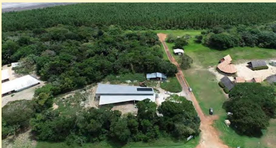
Vue drone le 31/03/2022 - La station SROG - © Tanguy Maury/UAR LEEISA)
