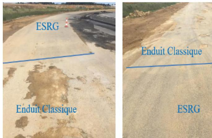
Figure 6 - Expérimentation sur le chantier Ariane 6 - Trafic chantier
