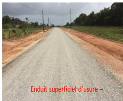
Enduit superficiel d'usure -
